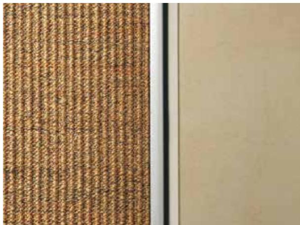
I profili STRIPTEC vengono impiegati per raccordare tra loro pavimenti di uguale o diversa natura e spessore. La forma arrotondata del profilo ne permette una leggera rotazione compensando differenze di livello max 5 mm. L'applicazione di STRIPTEC corregge le eventuali scheggiature dei pavimenti o il non perfetto accostamento in fase di taglio coprendo la giunzione. Utilizzabili anche come terminali di rivestimenti con spessore non superiore ai 5 mm.
